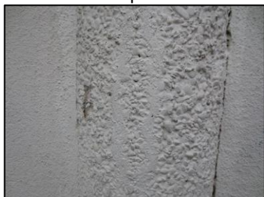
Photo N° 2893 ECH-N°33 -- Batiment 28-36 republique façade parking Poteaux béton+peinture
