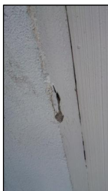
Photo N° 356 ECH-N°51 -- Batiment calmette façade arrière Murs béton+peinture beige
