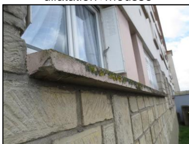
Photo N° 2897 ECH-N°37 -- Batiment 28-36 republique façade parking Appui de fenêtres béton+peinture
