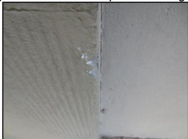
Photo N° 2862 ECH-N°16 -- Batiment Laennec façade jardin Murs soubassement béton+peinture
