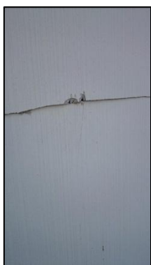
Photo N° 353 ECH-N°50 AMIANTE CIMENT Murs Plaques planes (Fibres-ciment)+peinture
