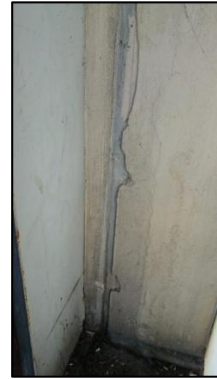
Photo N° 342 ECH-N°45 -- Batiment place villemin Murs béton+peinture
