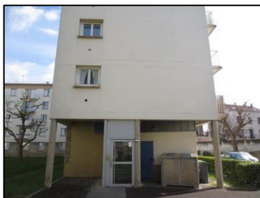
Photo N° 2888 ECH-N°39 -- Batiment 28-36 republique façade parking Murs béton+peinture beige
