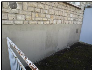
Photo N° 2830 ECH-N°1 -- Batiment 23-31 republique façade rue soubassement béton+peinture
