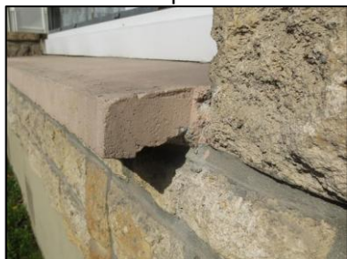
Photo N° 2884 ECH-N°29 -- Batiment Ambroise façade parking Appui de fenêtres béton+peinture
