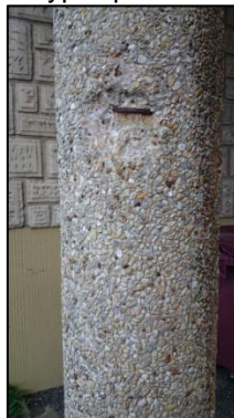
Photo N° 344 ECH-N°47 -- Batiment calmette porche Poteaux béton+pierres
