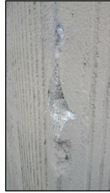
Photo N° 331 ECH-N°42 -- Batiment 24-26 republique pignon Murs soubassement béton+peinture
